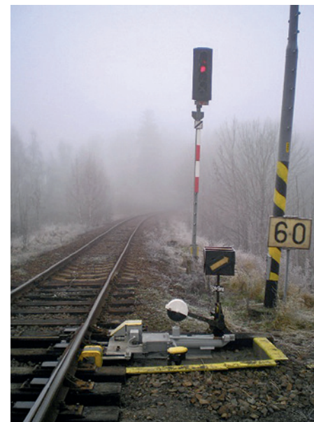
Vlevo: Výhybka se samovratným přestavníkem, foto: Tomáš Lajbl, http://vlaky.bestsite.cz
