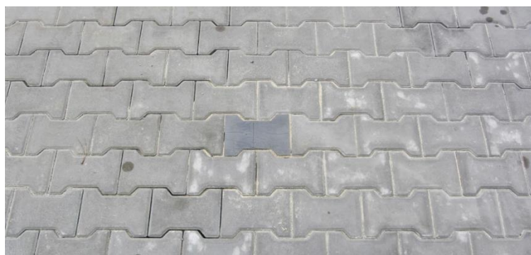
Obrázek 13: Ukázka magnetického detektoru integrovaného do dlažební kostky (Zdroj: CDV, v. v. i a CITIQ, s.r.o.)
