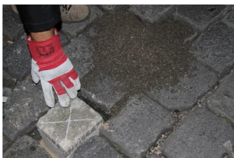
Obrázek 2: Dlažební kostka s integrovaným detektorem (vhodné pro instalaci v historické zástavbě)
