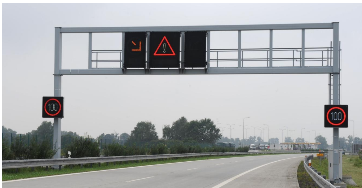
Portál liniového řízení provozu na D0
