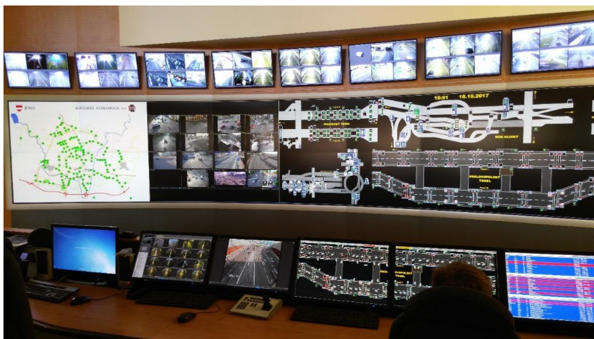
Operátorské stanoviště DIC v Brně
