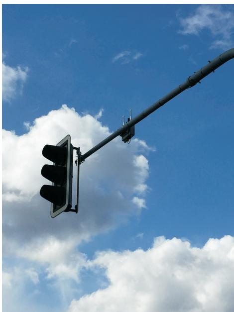
Obr. 3 Umístění komunikační jednotky RSU
