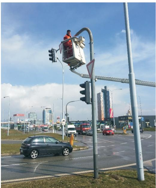
Obr. 2 Instalace jednotky RSU na výložník
