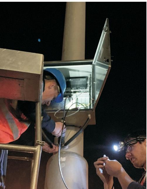
Obr. 4 Instalace jednotky RSU na sloupu VO
